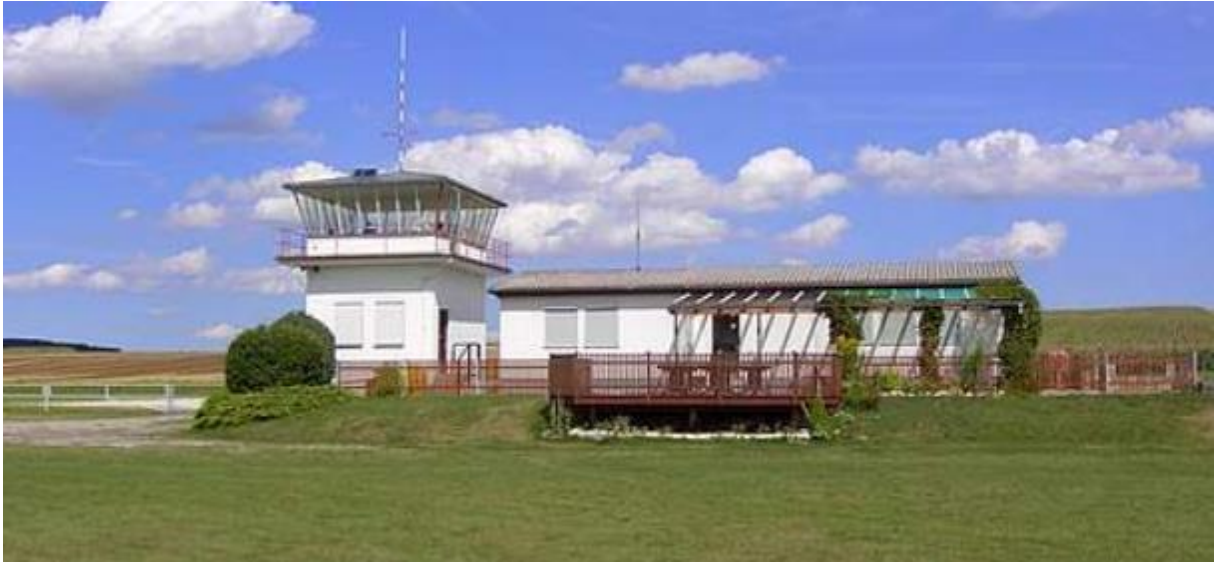
Abbildung 12: Aufnahme Flugverkehrskontrollturms - Quelle: http://www.oberpfalz-luftbild.de
