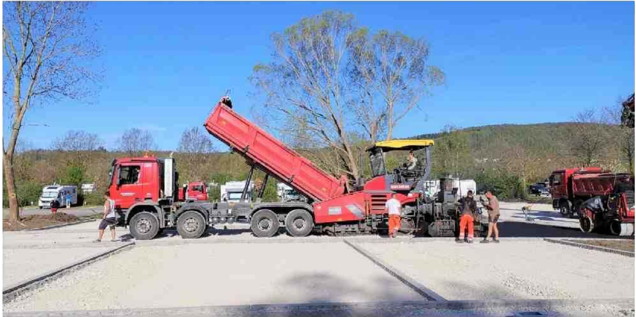
Reisemobilstellplatz während der Bauphase am 24. April 2019 - Einbau der Asphalttragschicht
