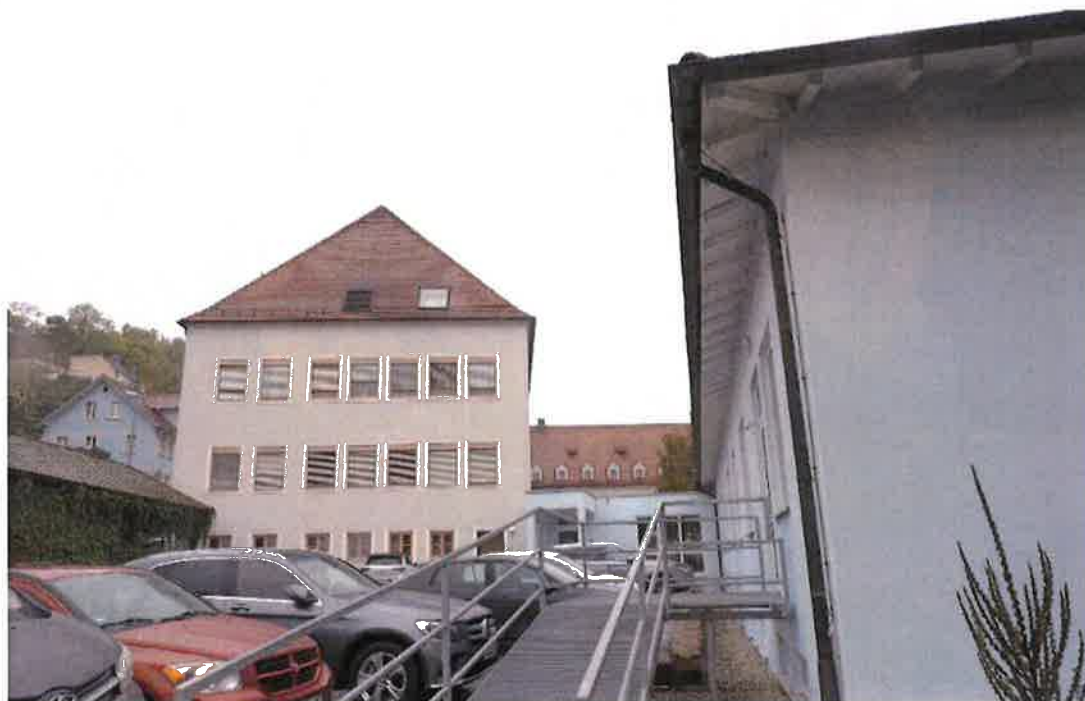
Abbildung 1: Altes Krankenhaus Treuchtlingen, Ansicht von Parkplatz aus
