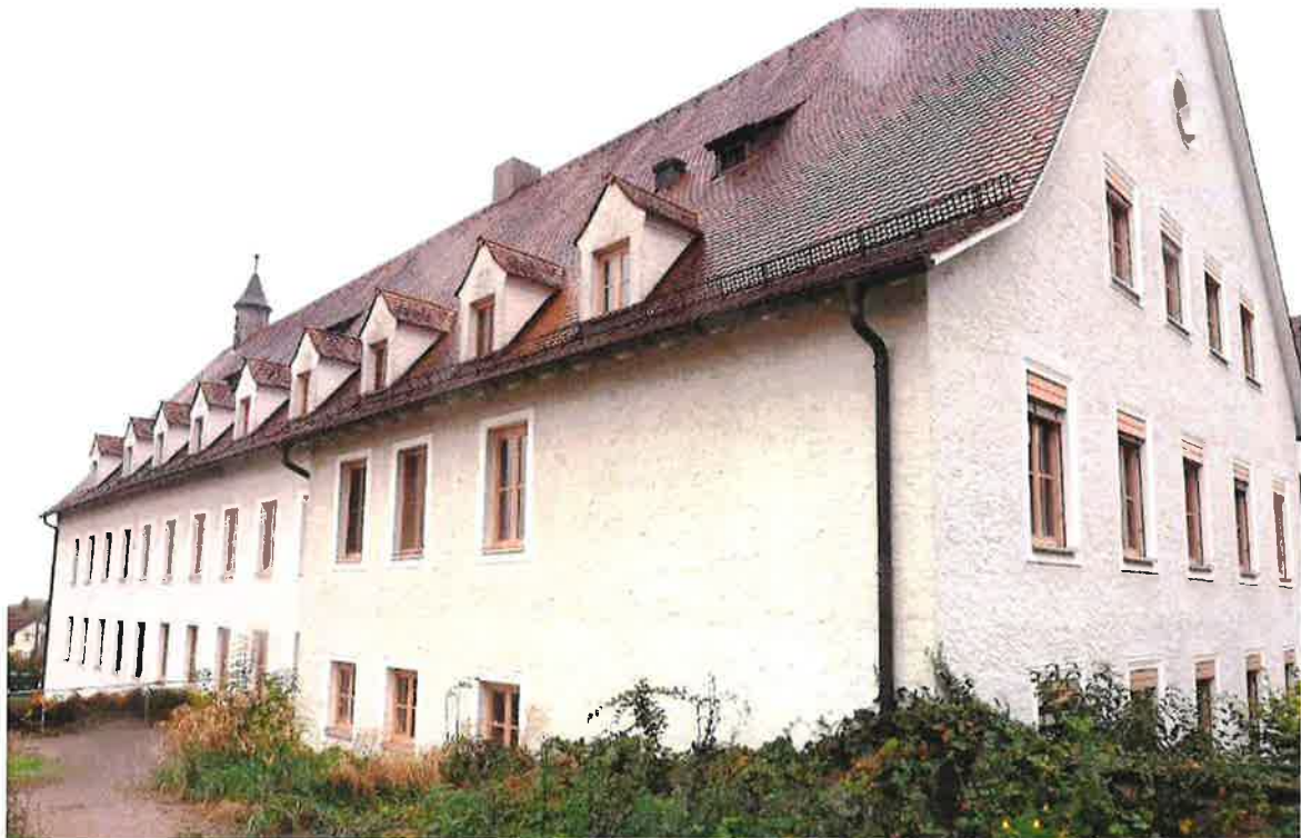
Abbildung 2: Altes Krankenhaus Treuchtlingen
